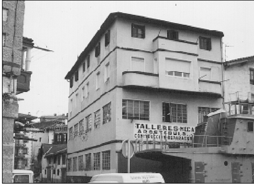
Itsasontziak muntatzen aritzen ziren Arostegi tailerrak Oriako itsasadarren ondoan jarri ziren. 1955ean hainbat solairuko eraikina eraiki zuten, jarduera solairuka garatzeko: beheko solairuan galdaragintza, lehen solairuan tailer mekanikoa eta doikuntza; bigarren solairuan biltegia eta azkenekoan etxebizitza. (1998ko argazkia, B. Herrerasena).
