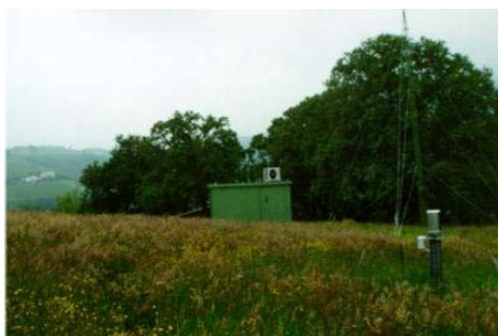
Estación de Control de Aire de Pagoeta. Fuente: Departamento de Ordenación del Territorio y Medio Ambiente del Gobierno Vasco
